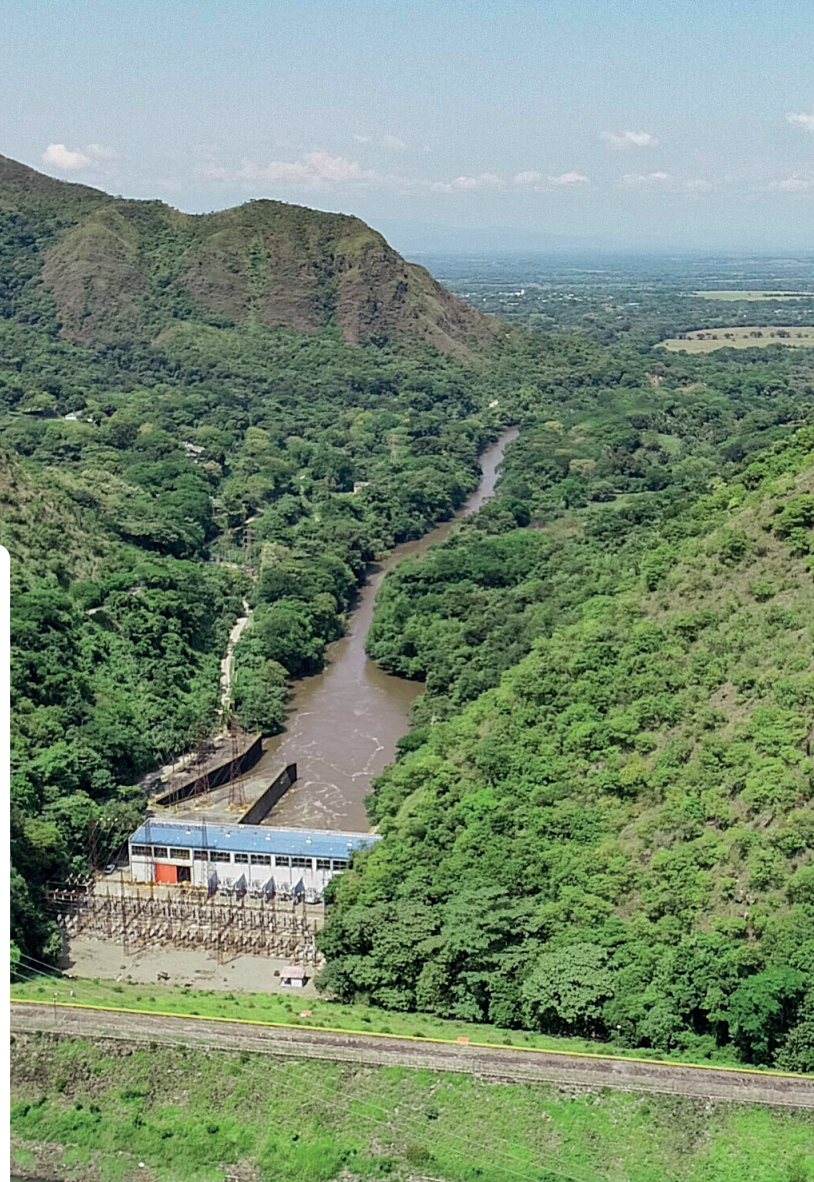
Central Hidroeléctrica de Prado, Tolima.
