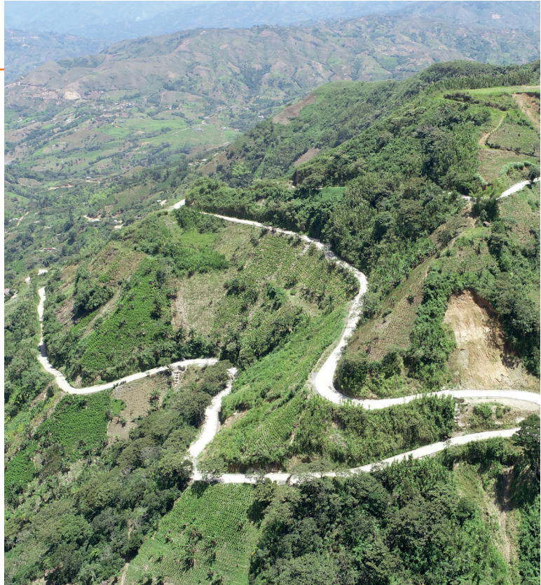
Avanzan las obras de pavimentación de la vía Morales- Pan de Azúcar, en Morales, Cauca.
