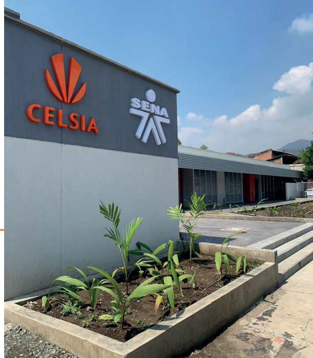
Centro de entrenamiento del Sena construido con el apoyo de Celsia, donde se espera formar unas 1.400 personas al año.
