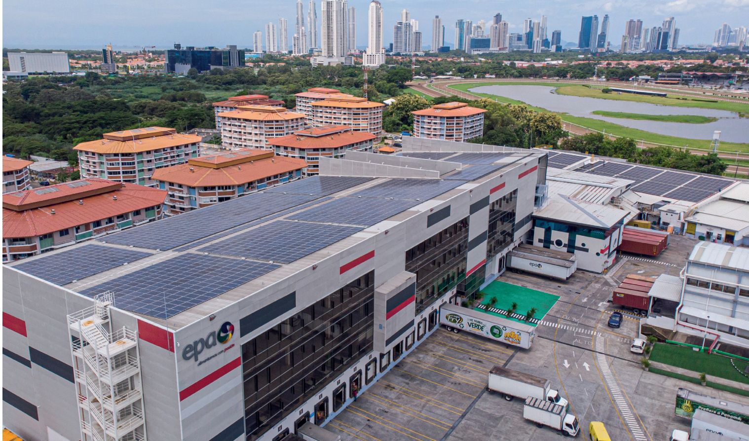
Techo solar Empresa Panameña de Alimentos (EPA).
