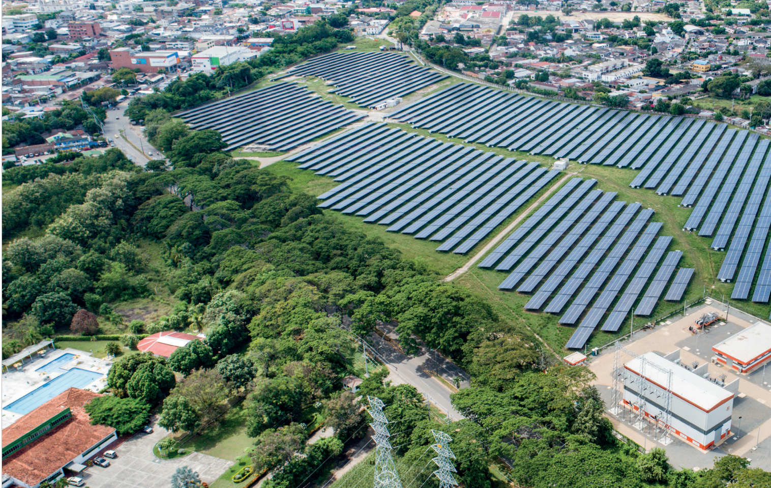
Subestación Nueva Espinal y Celsia Solar Espinal, Tolima.
