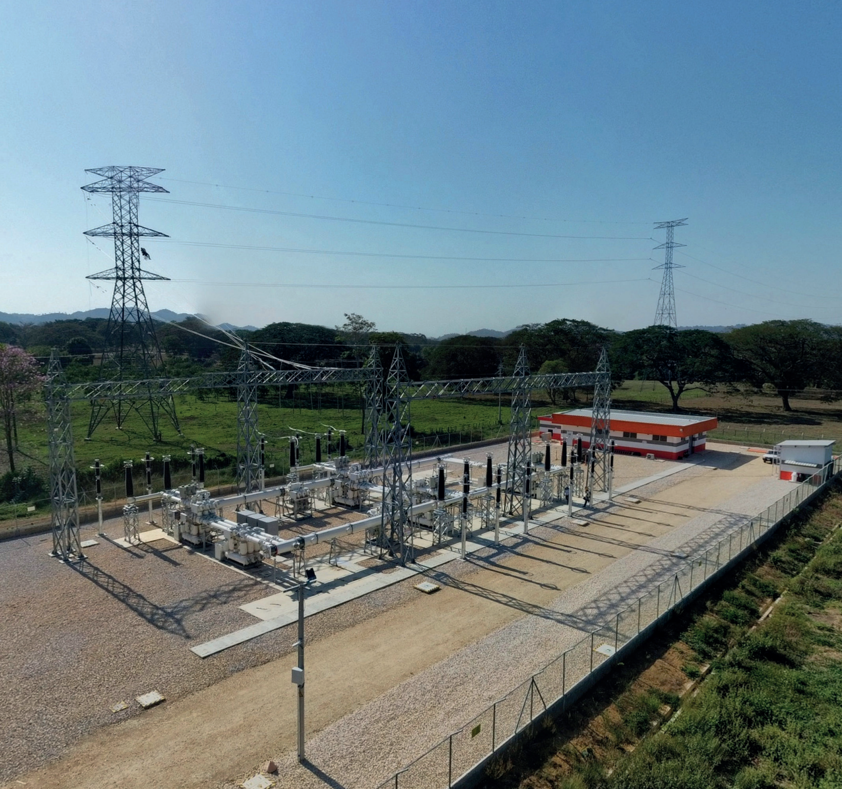
La subestación Tolviejo (Sucre), de 220 kV, en la fase final de construcción. Incluye el montaje de 160 km de líneas de transmisión Chinú – Tolviejo y Tolviejo – Bolívar.
